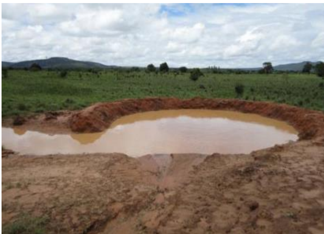
Figura 6: Bacia de captação
