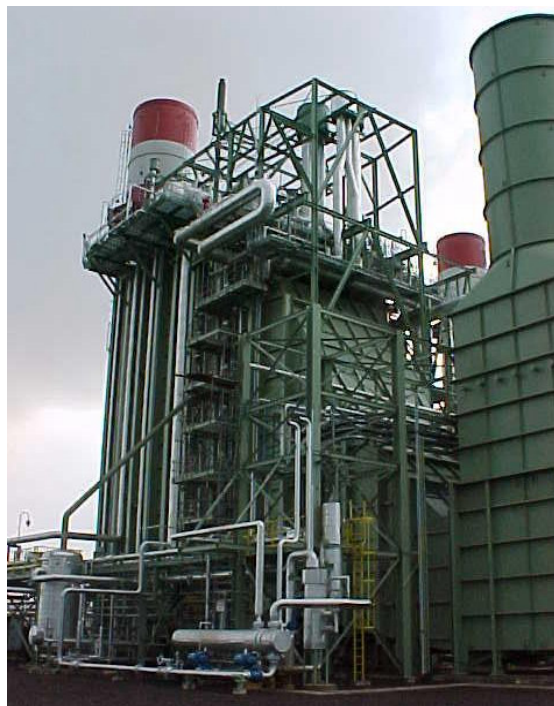
Figura 2.20 – Caldeira de recuperação sem queima suplementar.
