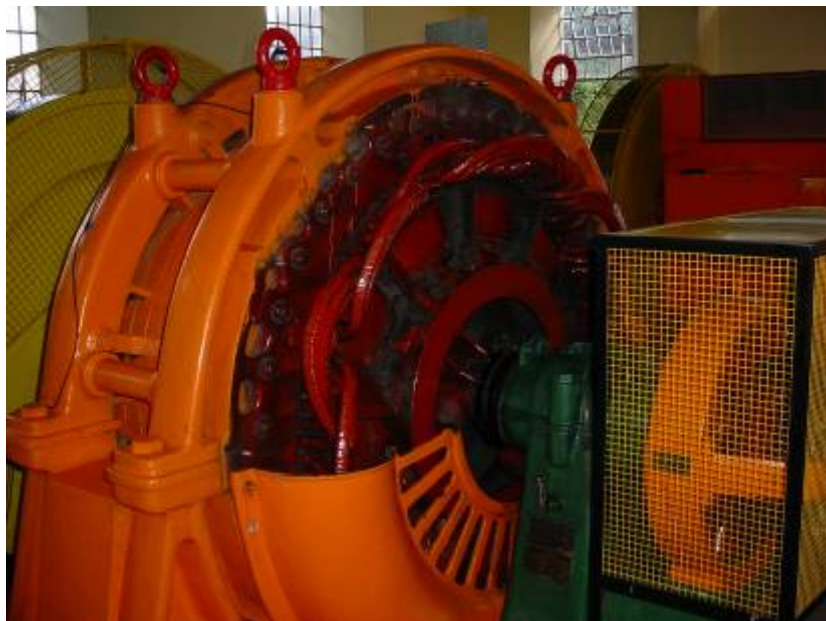
Figura 59 – Detalhe do cabo fixado na armadura do gerador
