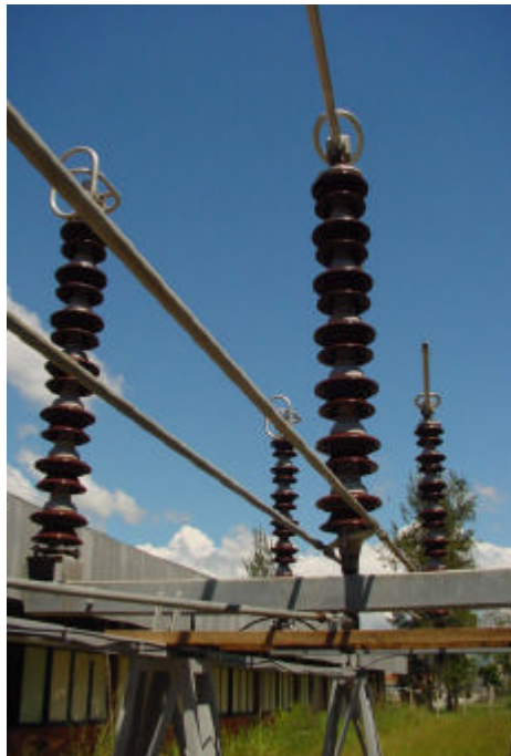
Figura 1.2 – Destaque das barras paralelas responsáveis pelo fechamento/abertura.
