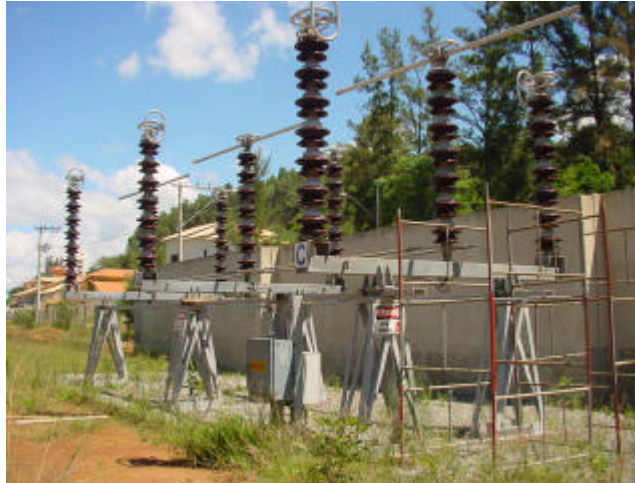
Figura 1.1 – A chave seccionadora.
