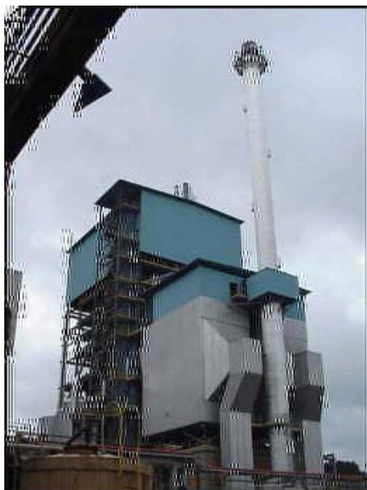
**Figura 3.7** – Vista geral do precipitador eletrostático acoplado à chaminé e CRQ ao fundo (NOBRECEL, 2003)
