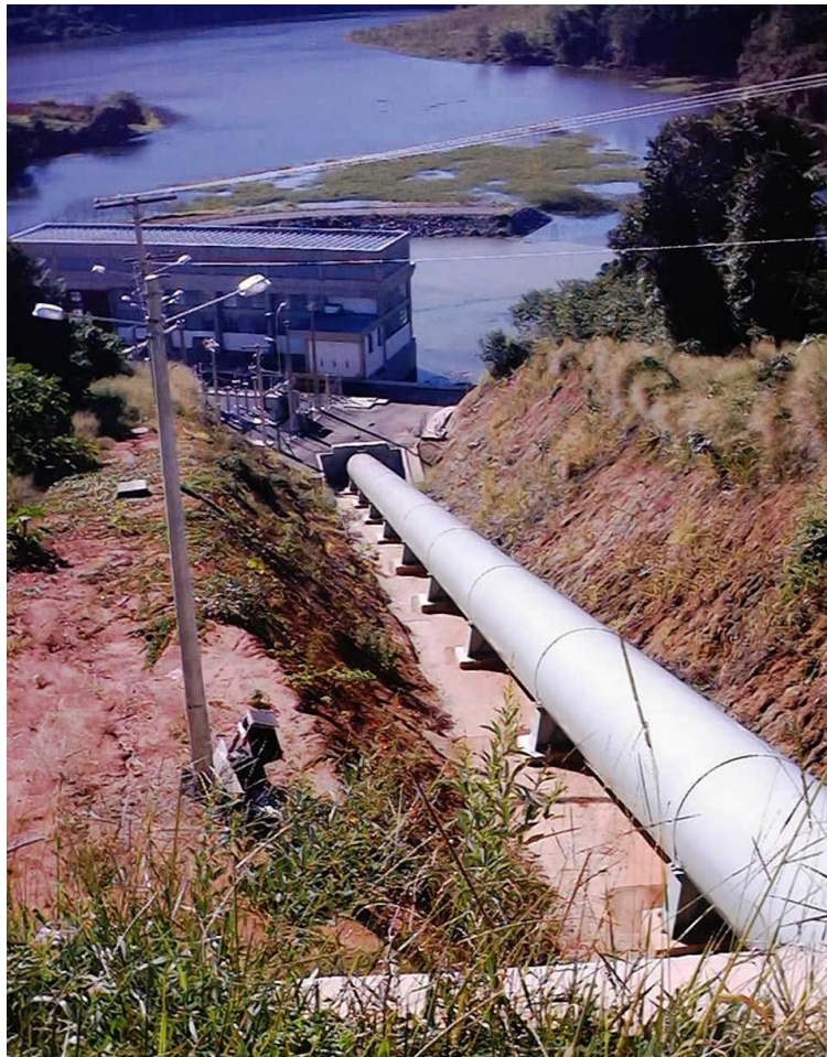
Figura 5.1 - Conduto forçado da Usina Antas II em Poços de Caldas (MG-Brasil)
