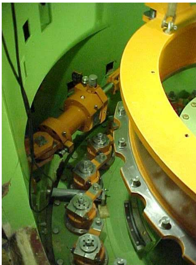
Figura 6.10 - Vista do servomotor principal do regulador da Usina Santa Clara (M.G.)
