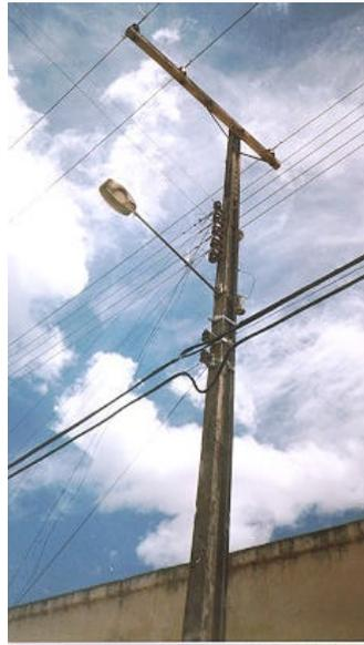
**Figura 4.1.2 – Luminária Aberta com Lâmpada de VS de 70 W**
