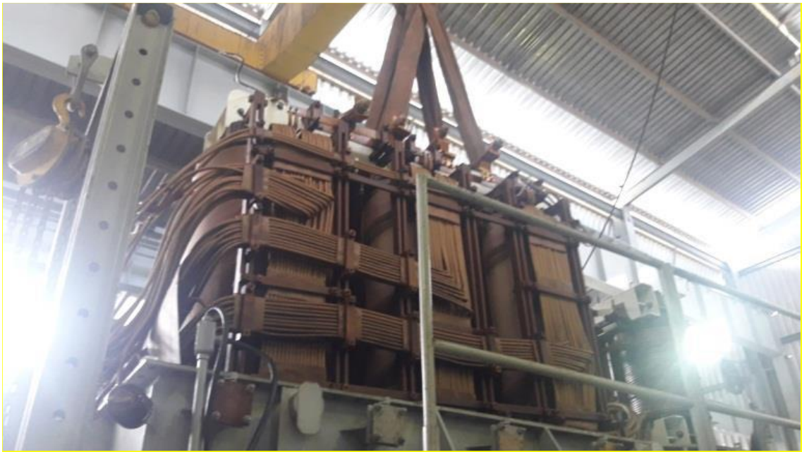
Figura 71 - Remoção da parte ativa
