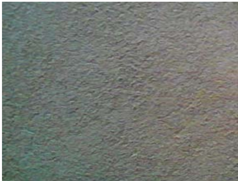
Figura 5.6 – Painel revestido com argamassa produzida com escória/granito.
