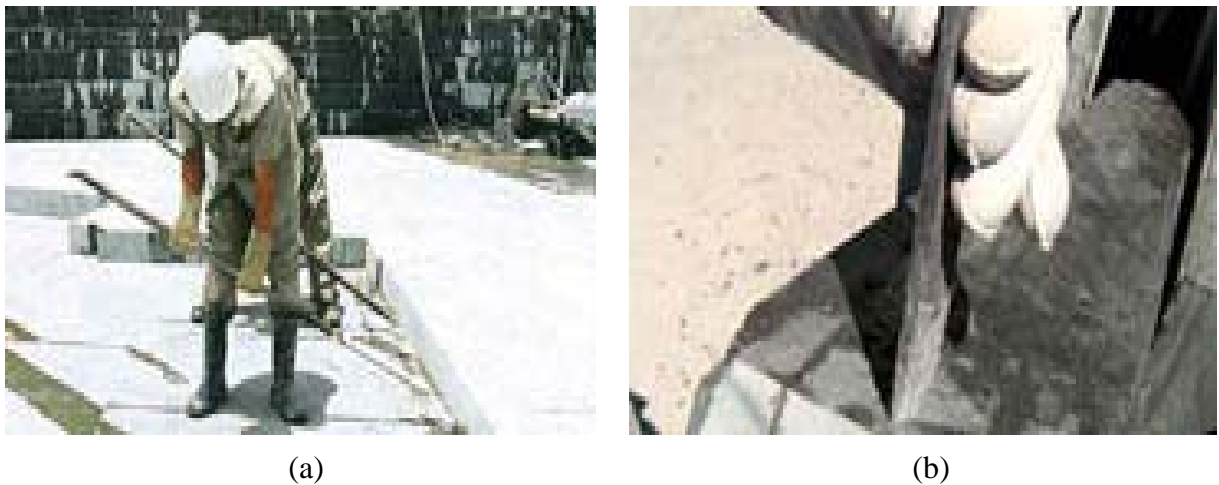
Figura 2.8 - Extração (a) e descolamento das chapas de ardósia (b).
