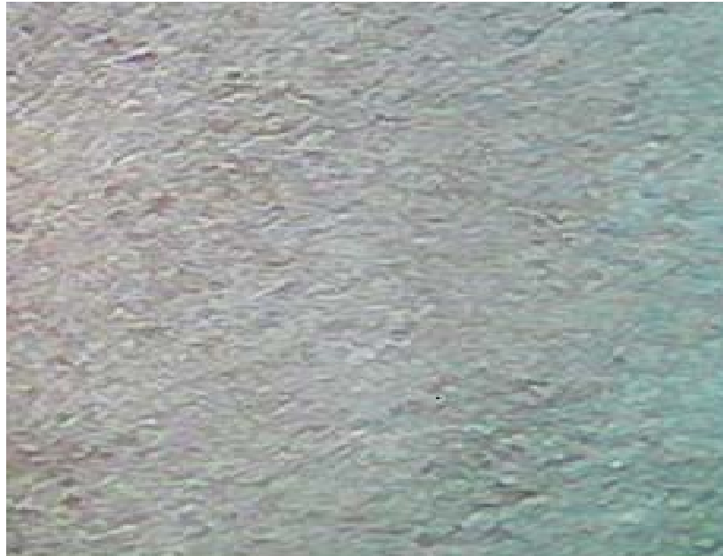
Figura 5.5 – Painel revestido com argamassa convencional.
