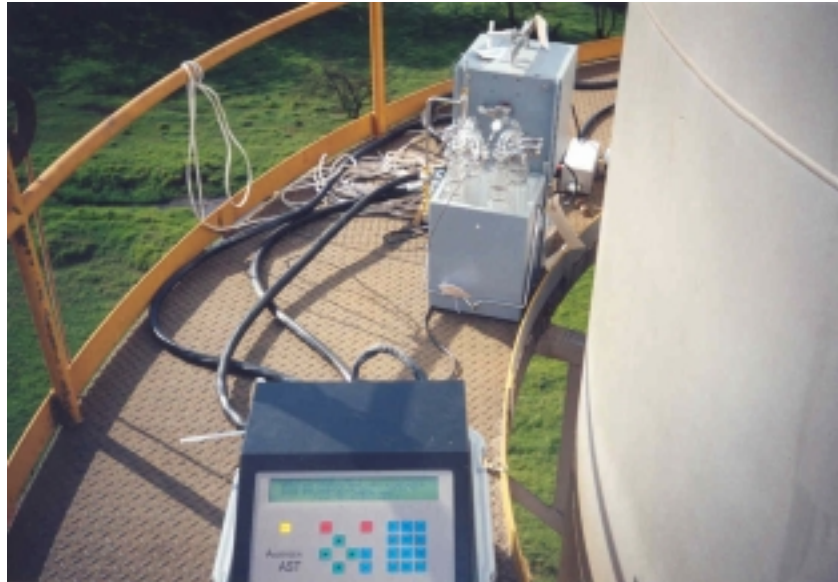
Figura 4.25- Equipamento montado na plataforma da chaminé
