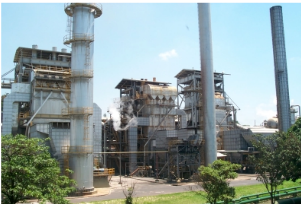
Figura 4.26- Vista parcial da caldeiras e as três chaminés 1, 2 e 3 (da esquerda para a direita) da Usina Barra Grande
