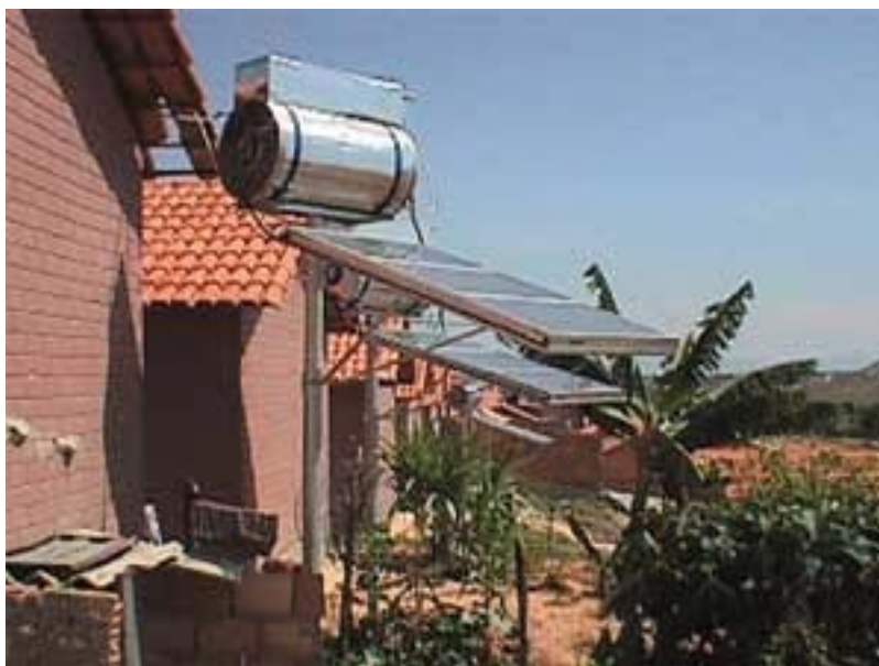
Figura 1.3: Instalação independente (CEST, 2003).
