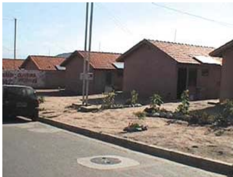
Figura 1.4: Vista do conjunto habitacional (CEST, 2003).
