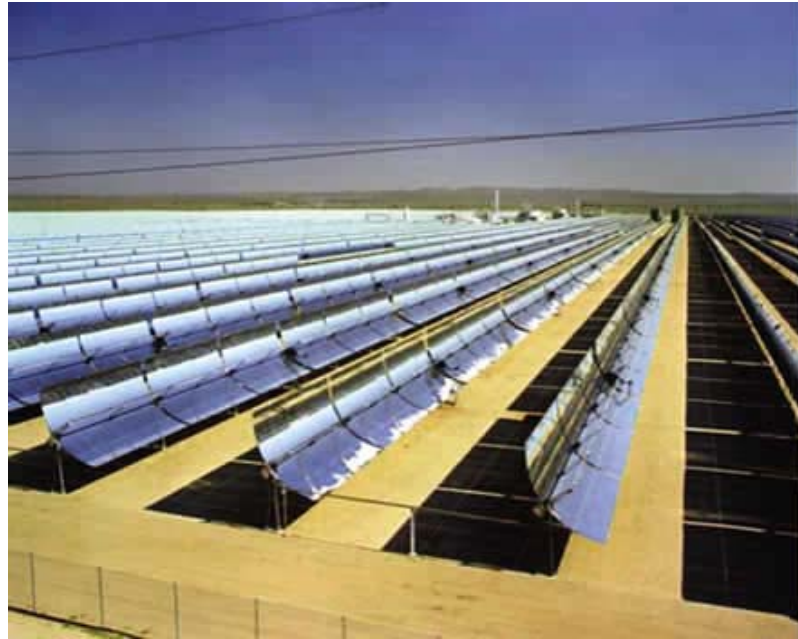
Figura 1.9: Coletores solares concentradores de um sistema térmico de geração solar de energia elétrica localizado na Califórnia ( www.aneel.gov.br ).
