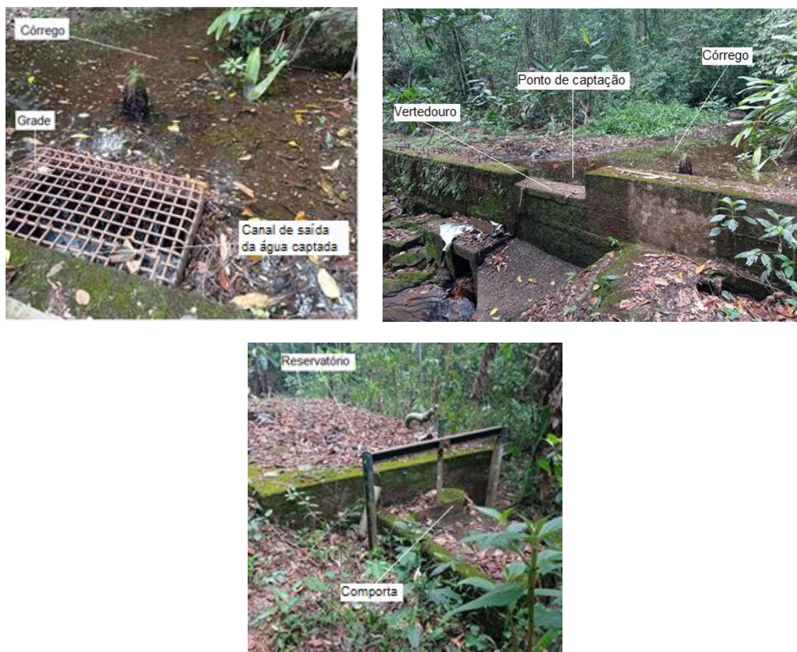
Figura 38 - Captação no córrego Boa Vista
