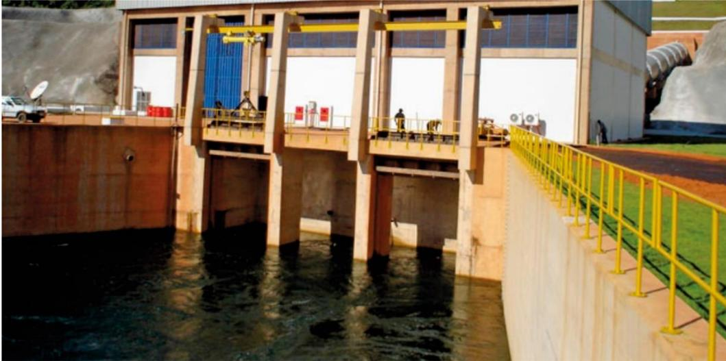
Figura 3-19 - CANAL DE FUGA DA PCH GARGANTA DA JARARACA. Fonte: Atiaia Energia.
