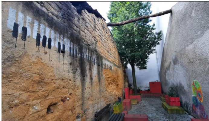
Figura 63 – Entre construções | Águeda-PT Fonte: Acervo Pessoal
