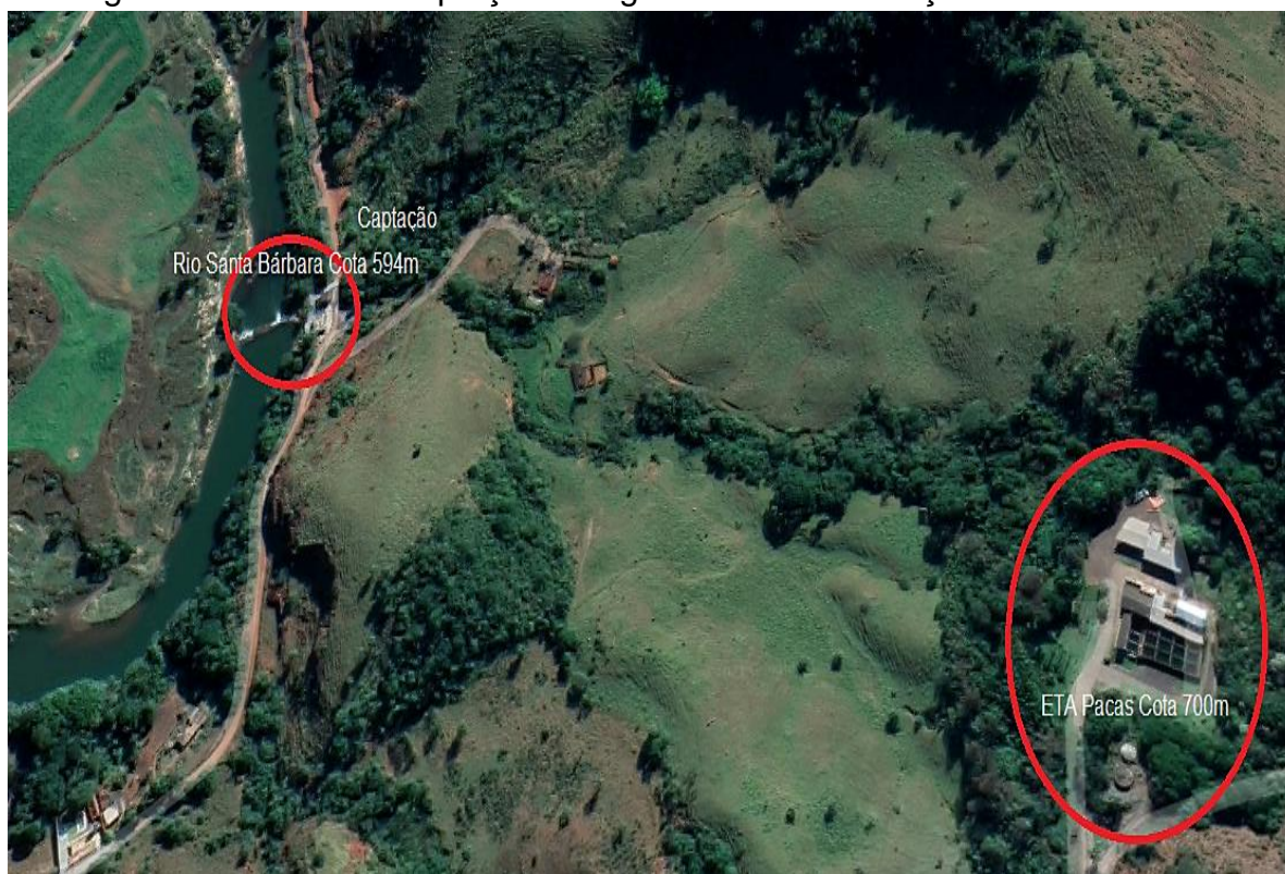
Figura 10 - Ponto de captação de água bruta e localização da ETA Pacas
