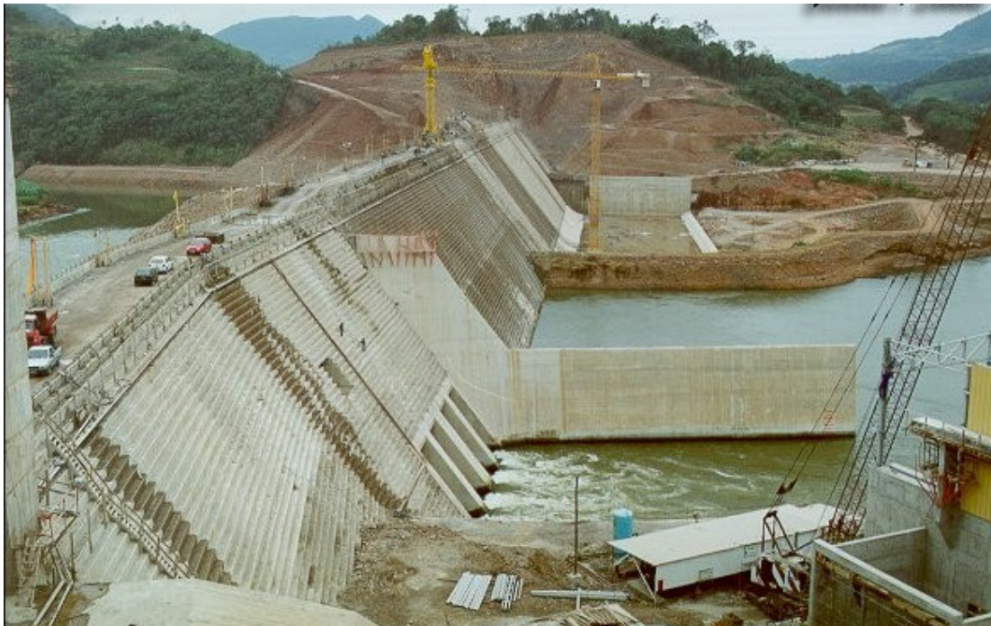
Figura 28 – Detalhe do paramento de jusante em CCV da UHE Dona Francisca. Fonte: COPEL.
