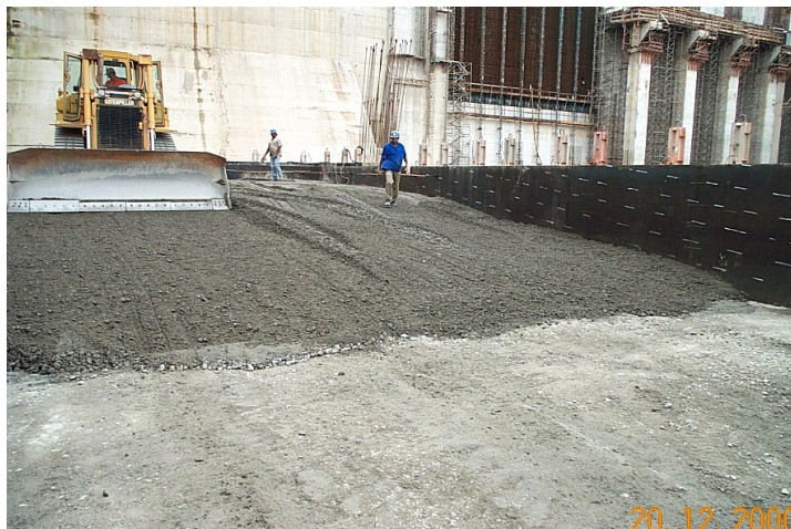
Figura 36 – Controle de inclinação das camadas de CCR na UHE Lajeado. Fonte: Furnas Centrais Elétricas
