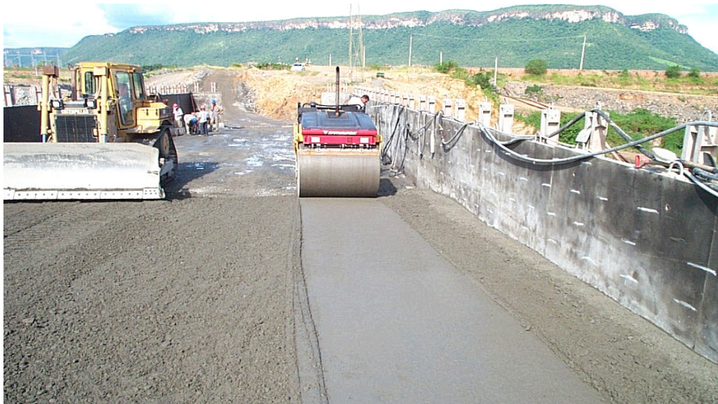
Figura 14 – Compactação com o rolo vibratório na UHE Lajeado. Fonte: Furnas Centrais Elétricas S.A.
