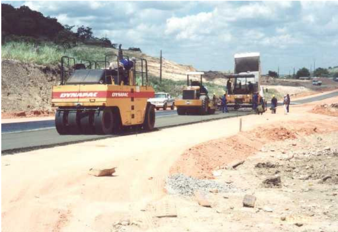
Figura 25 – Pavimentação da BR-232 em CCR. Fonte: Associação Brasileira de Cimento Portland.
