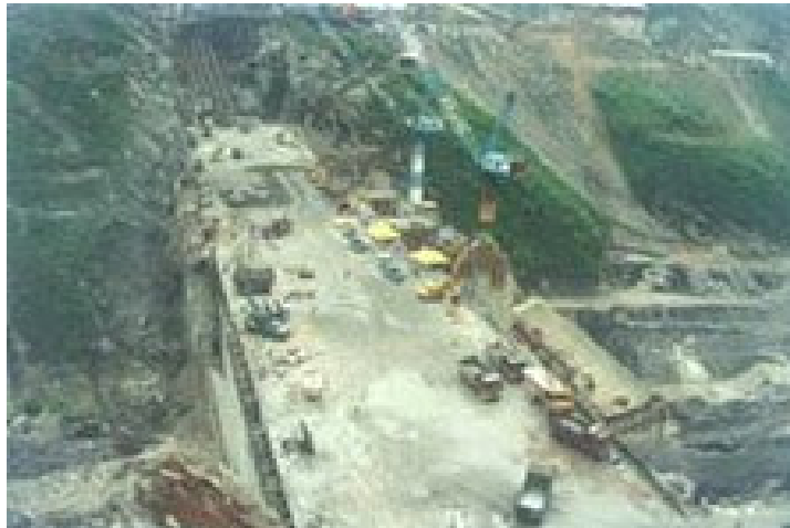
Figura 32 – A barragem de Jiangya durante a construção Fonte: International Water Power & Dam Construction
