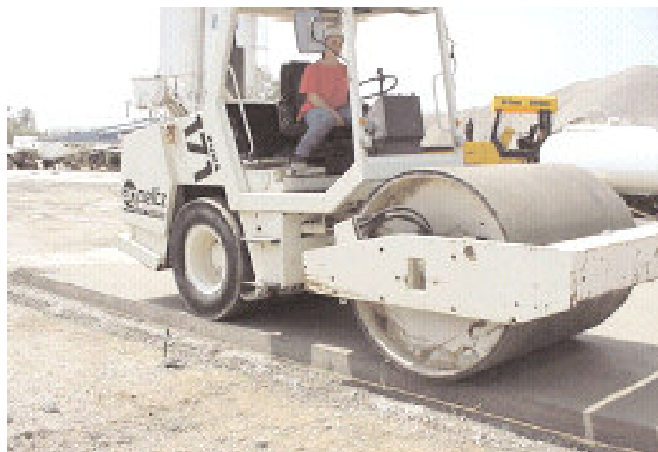
Figura 26 – Compactação de pavimento industrial da Honda – EUA. Fonte: RCC Newsletter – Summer 2001, v.17, n. 1.
