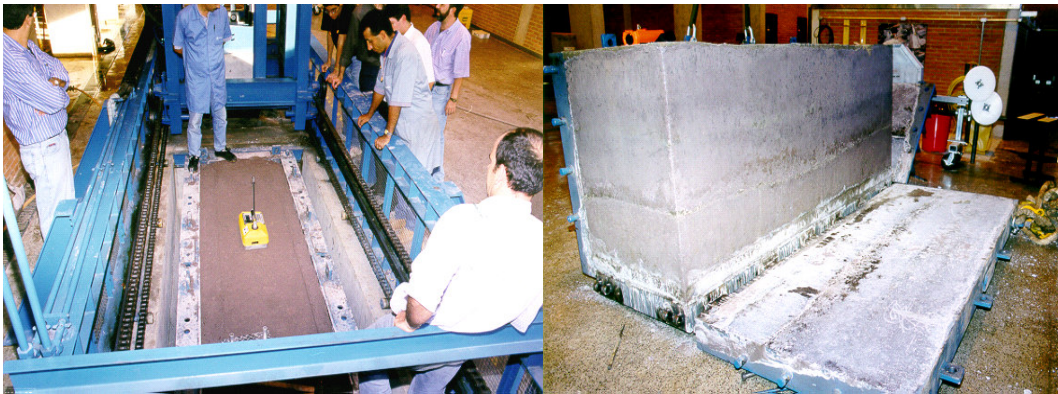
Figura 19 – Pista experimental CCR do laboratório de concreto de Furnas – Goiânia Fonte: Furnas Centrais Elétricas S.A.
