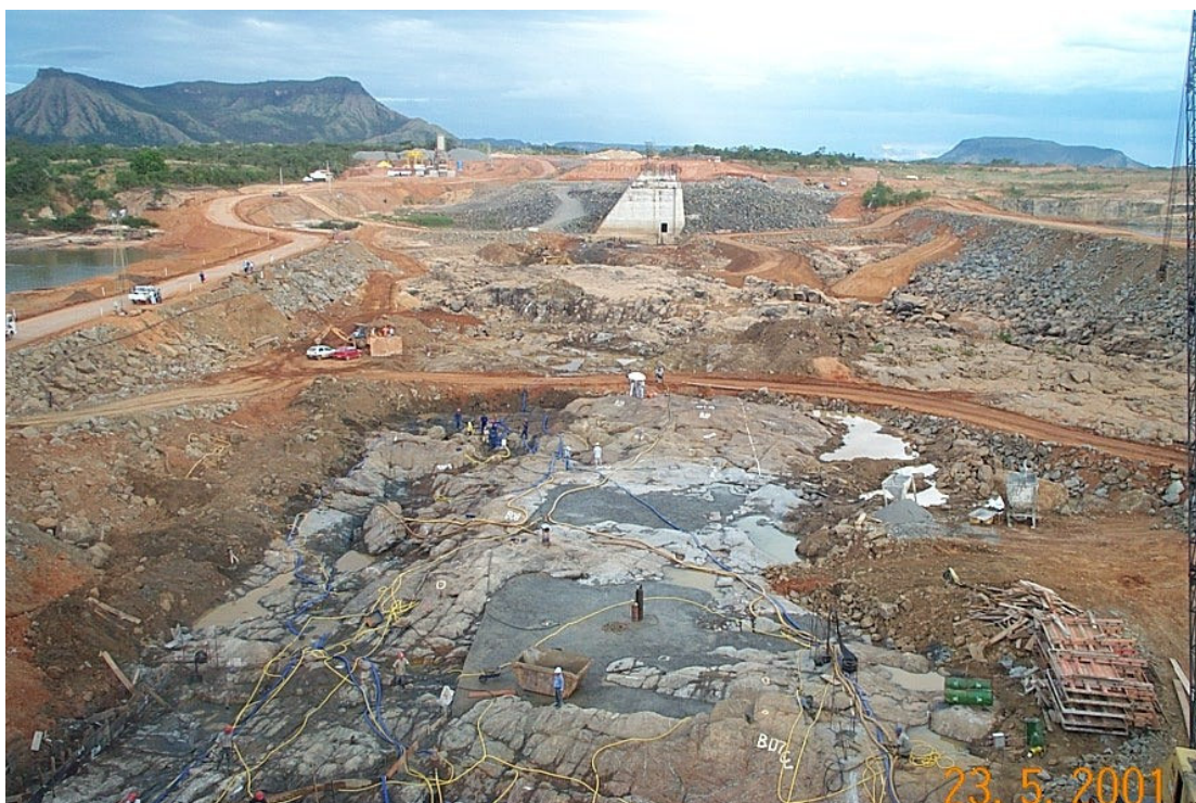
Figura 8 – Preparação da fundação na UHE Lajeado. Fonte: Associação Brasileira de Cimento Portland.
