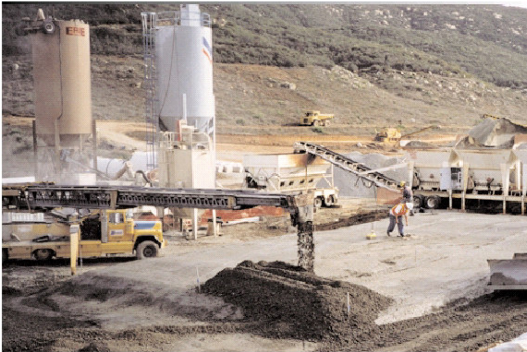
Figura 18 – Pista experimental de campo da barragem Olivenhain – USA. Fonte: RCC Newsletter Summer 2000, v. 16, n. 1.
