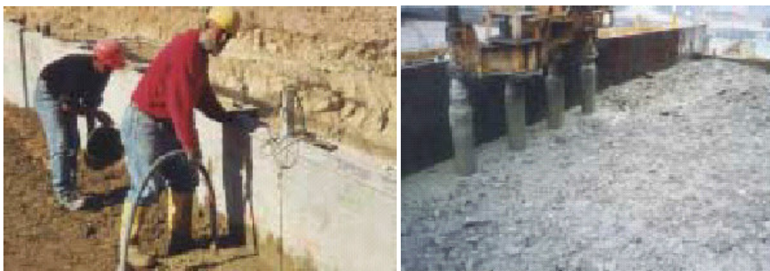
Figura 31 – Processos de adensamento do GERCC em Tannur e Jiangya Dam. Fonte:International Water Power & Dam Construction.
