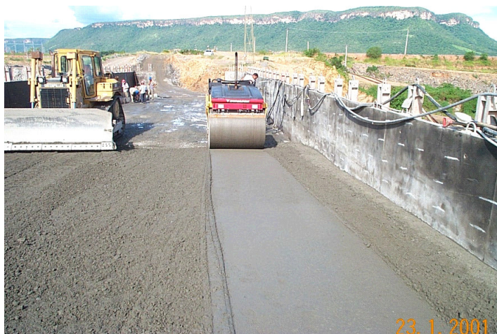
Figura 33 – Detalhe da inclinação das camadas na UHE Lajeado. Fonte: Furnas Centrais Elétricas S.A.
