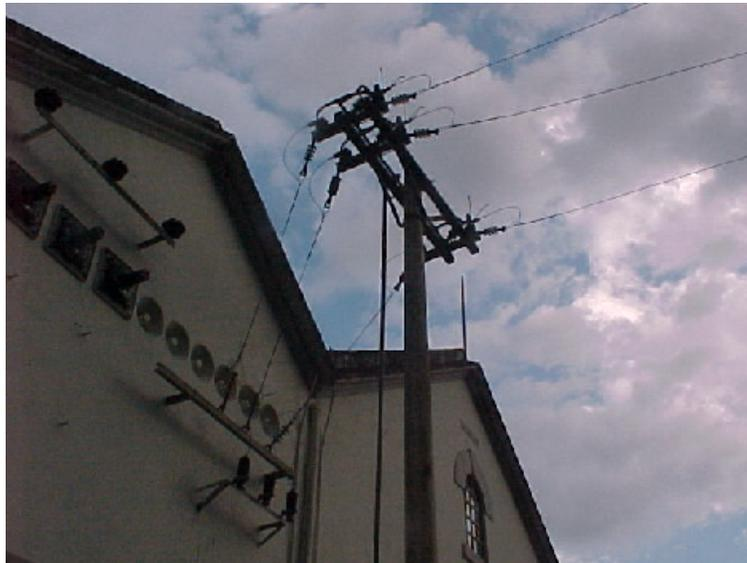
Figura 4.6 – Entrada de Energia com Dispositivos de Proteção e Distribuição
