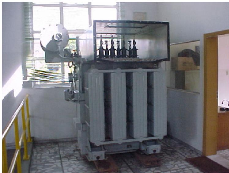
Figura 4.2 – Exemplo de Transformador 750 kVA
