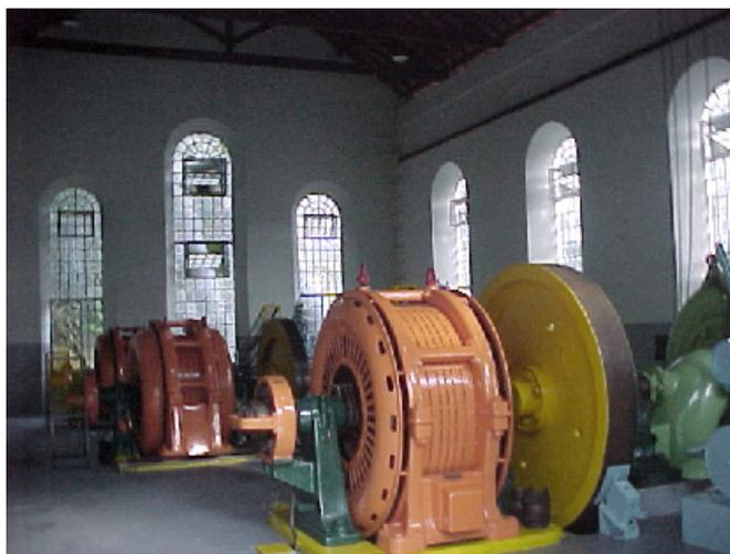
Figura 2.1 – Gerador Síncrono 810 kW
