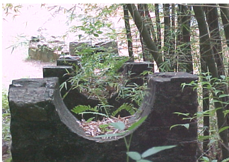
Figura 25 (a) e (b) – Blocos de ancoragem e casa de força, PCH Pancada Grande.
