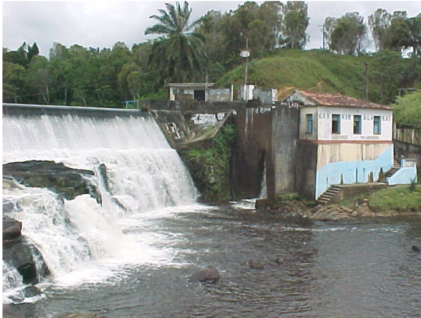
Figura 8 – Vista da barragem e casa de força da Usina Francisco Borges, rio Acaraí.
