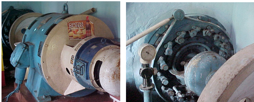
Figuras 9 (a) e (b) – Gerador e turbina da Usina Francisco Borges.
