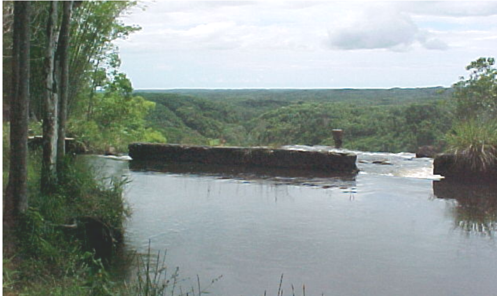
Figura 24 – Vista da barragem existente da antiga Usina Pancada Grande.
