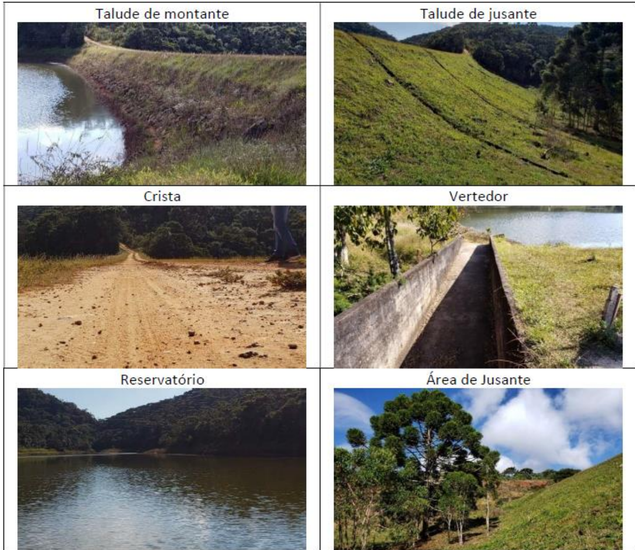
Figura 3-11 : Visão Geral da barragem Brejo Grande - Paraisópolis MG
