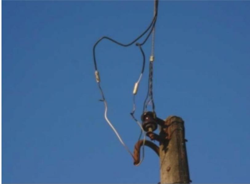
Figura 3.25- Exemplo de problema na conexão no pontalete
