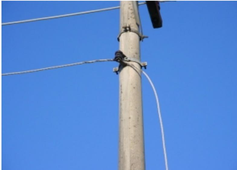
Figura 3.19- Exemplo de cabo interrompido
