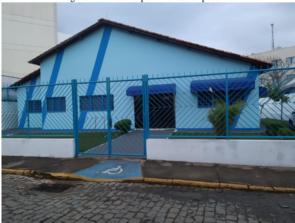
Figura 11 - Vista da parte frontal do postinho.
