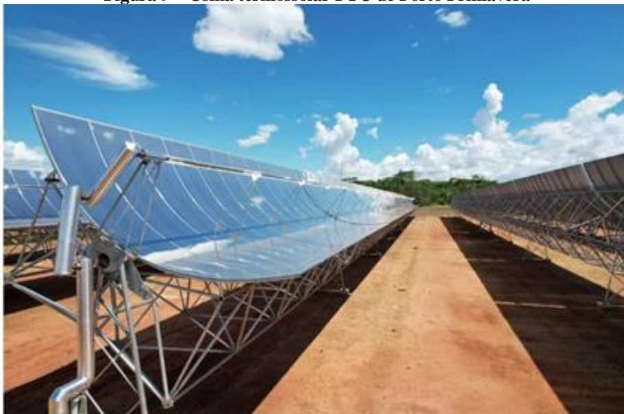
Figura 9 – Usina termossolar PTC de Porto Primavera
