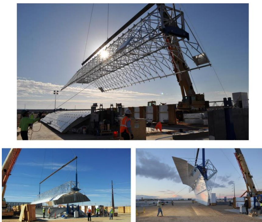
Figura 15 – Rotação e posicionamento da estrutura de aço do Ultimate Trough
