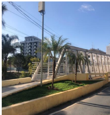
Figura 37 - Ponte de acesso a cidade reformada em 2021
