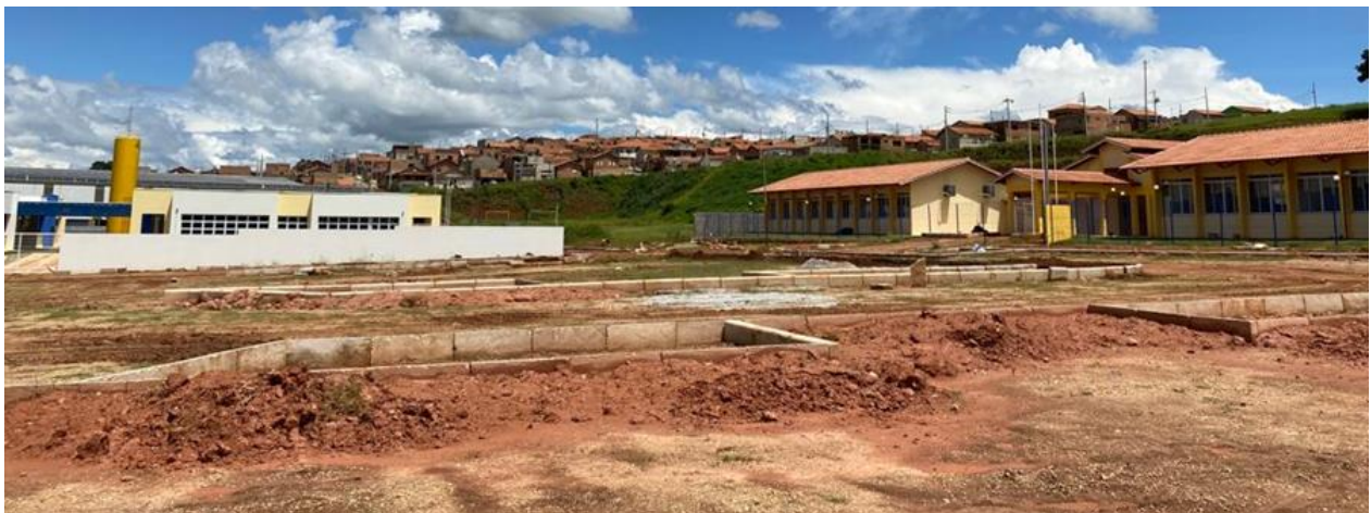
Figura 43 - Área de construção do processo construtivo
