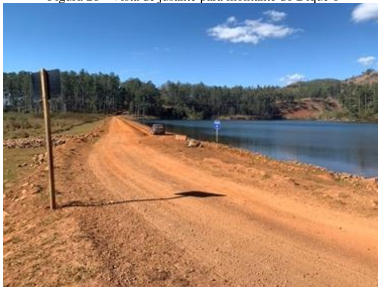
Figura 28 - Vista de jusante para montante do Dique 6
