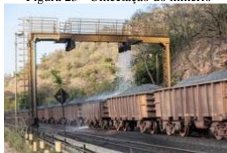
Figura 23 - Umectação do minério
