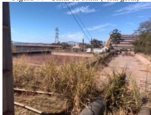
Figura 44 - Canal da usina (vista geral)
