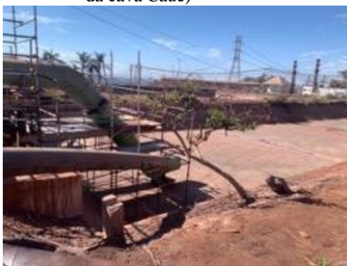
Figura 43 - Canal da Usina (entrada de água da cava Cauê)
