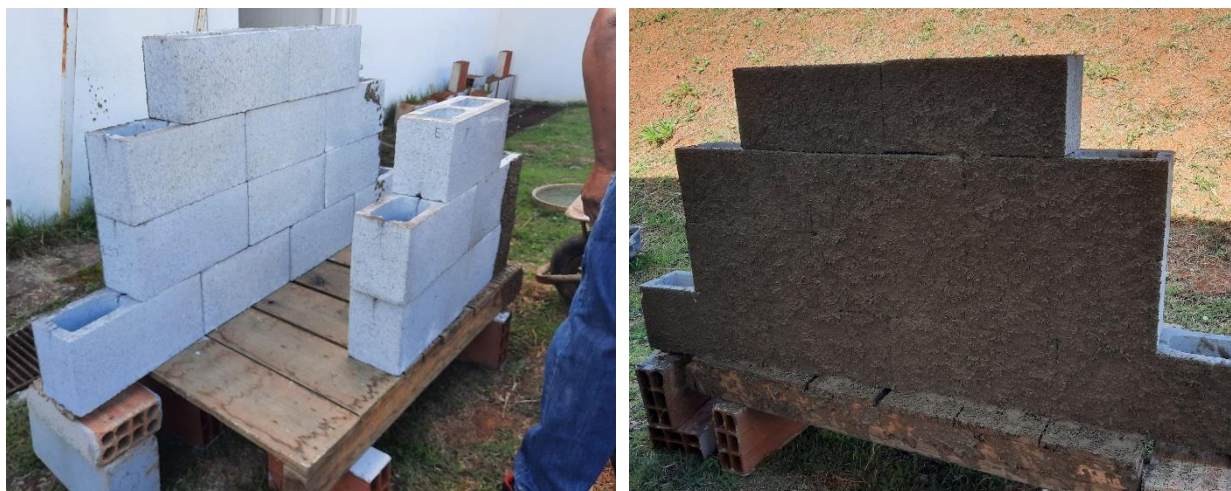
Figura 14 - Preparo do substrato para assentamento das argamassas
