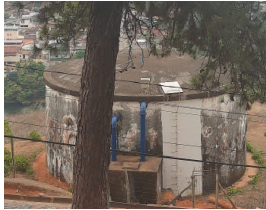
Figura 28: Reservatório de água tratada
