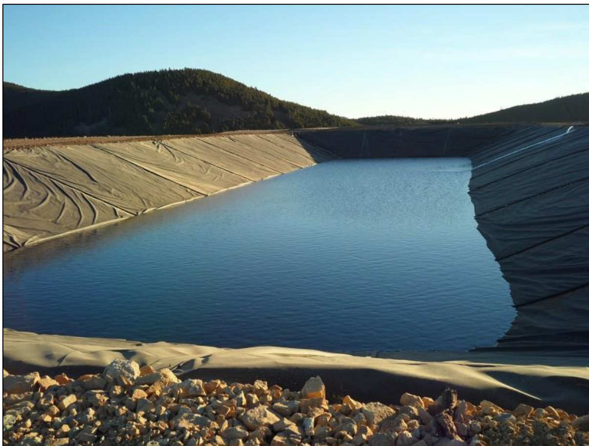
Figura 30 – Exemplo de revestimento de reservatório com geomembrana PEAD
