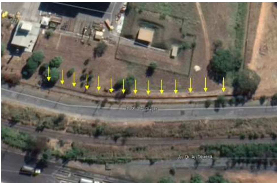
Figura 20 - Local da Calha de Escoamento da Água Pluvial
