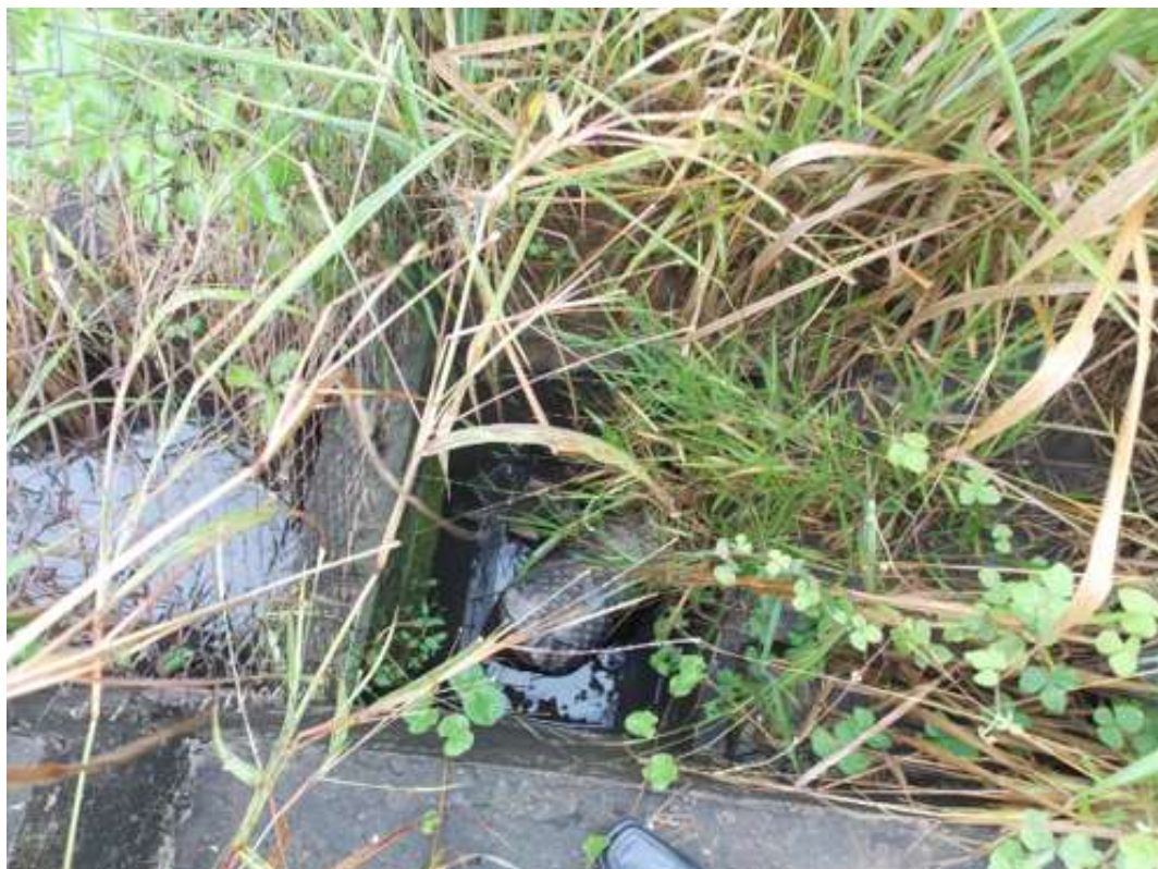
Figura 22 - Ponto de Captação da Água Pluvial da Empresa X
