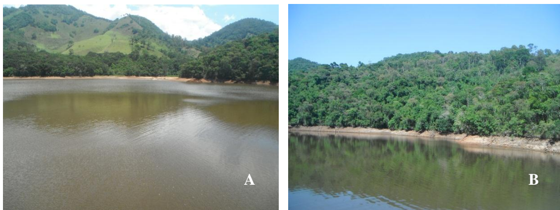
Figura 4: Detalhe do reservatório da Indústria de Material Bélico do Brasil - Imbel em Wenceslau Braz-MG.
