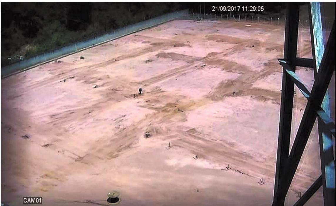
**Figura 74 - Fechamento das valas após colocação dos eletrodutos e do aterramento**
