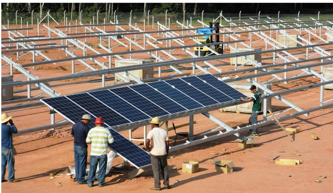
**Figura 78 - Colocação dos painéis solares**
