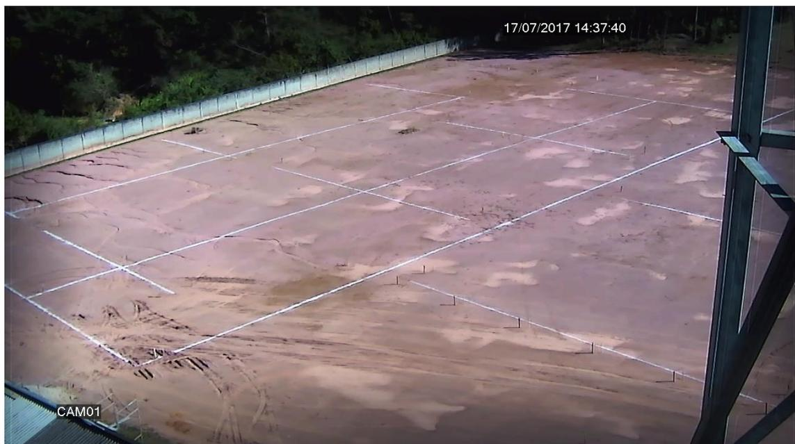
**Figura 72 - Marcação topográfica da posição das valas e estacas**
