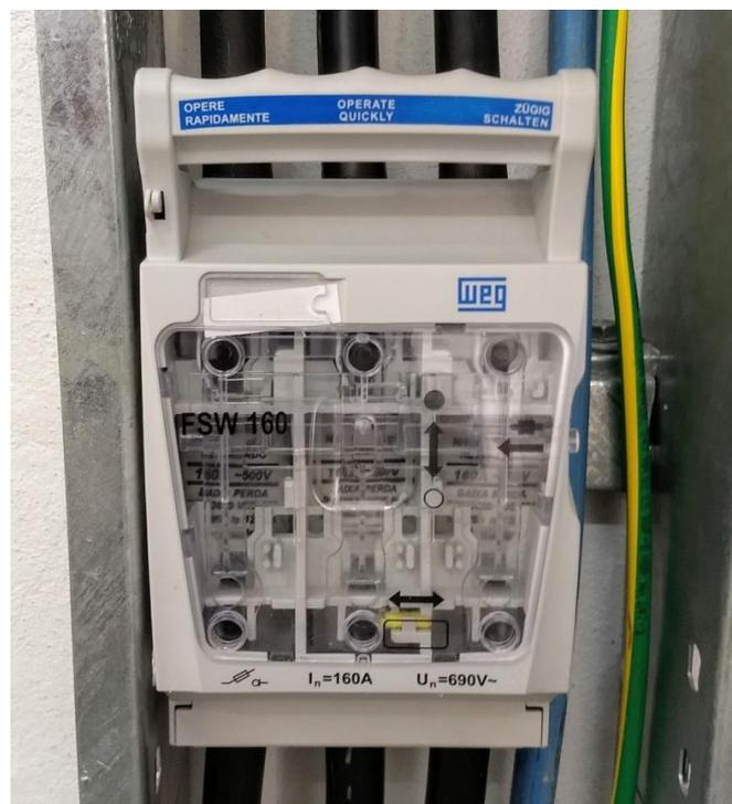
Figura 94 - Chave seccionadora saca fusível
