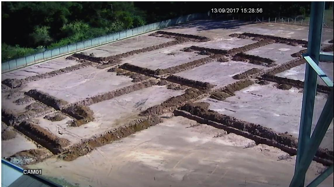
**Figura 73 - Escavação de valas para passagem de cabos e do aterramento**
