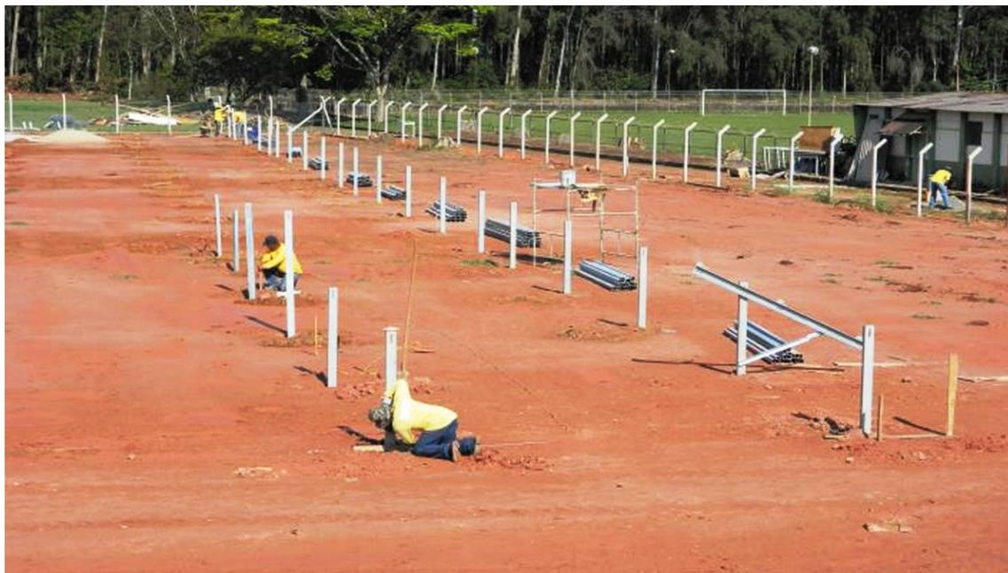
**Figura 75 - Colocação das estacas**
