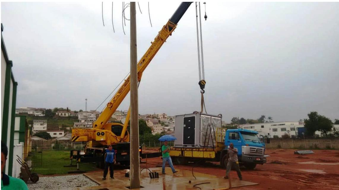
**Figura 81 - Posicionamento da estação de média tensão**
