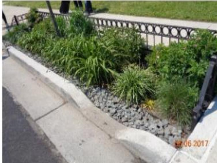
Figura 10 - Canteiro pluvial
