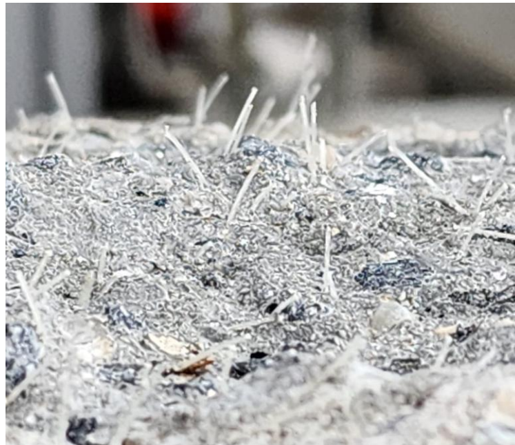
Figura 48: Detalhe das fibras após o ensaio de flexão viga de CVV.
