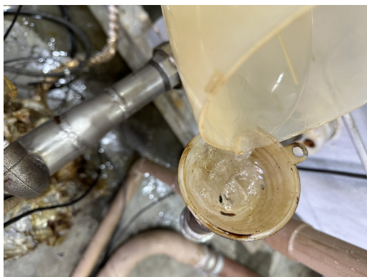
Figura 60 – Injeção do solvente no trecho com deposição.
