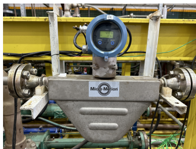
Figura 55 – Medidor de vazão e temperatura Coriolis para a corrente de petróleo.
