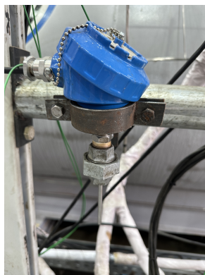
Figura 57 – Medidor de temperatura do tipo Pt100.
