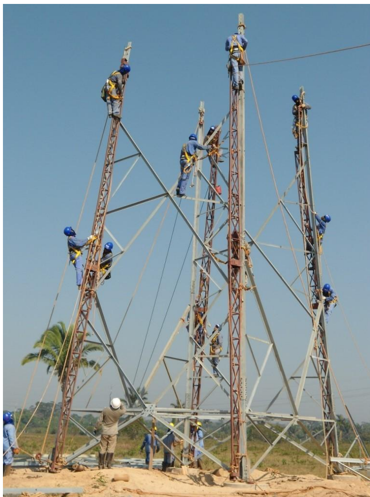
Figura 4.11: Montagem de torre de transmissão de energia (Castro, 2015)
