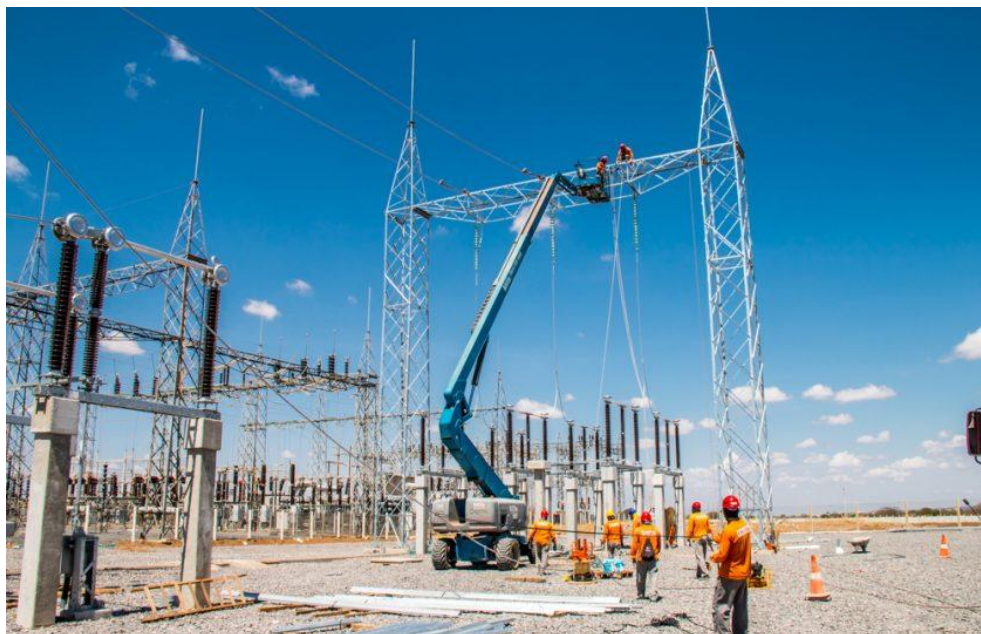
Figura 4.12: Montagem eletromecânica de subestação de energia (GEL, 2025)
