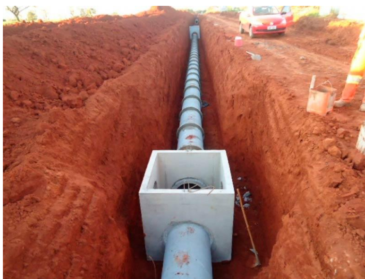
Figura 4.9: Instalação de sistema de drenagem em terreno (NE, 2025)
