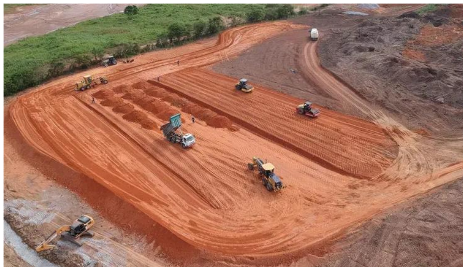
Figura 4.7: Execução de terraplenagem (ETS, 2025).
