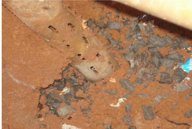
**Figura 9:** Detalhe das perfurações dos drenos com britas em seu entorno
