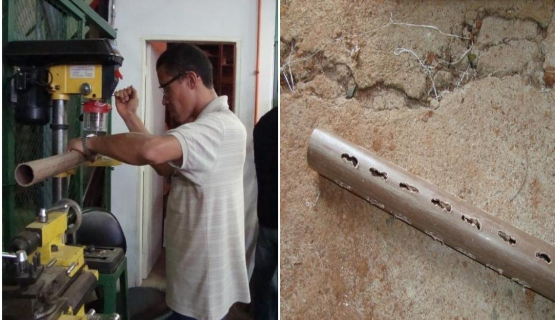
**Figura 5:** a) Confecção de drenos (esquerda); b) Fendas dos drenos para captação do biogás (direita).
