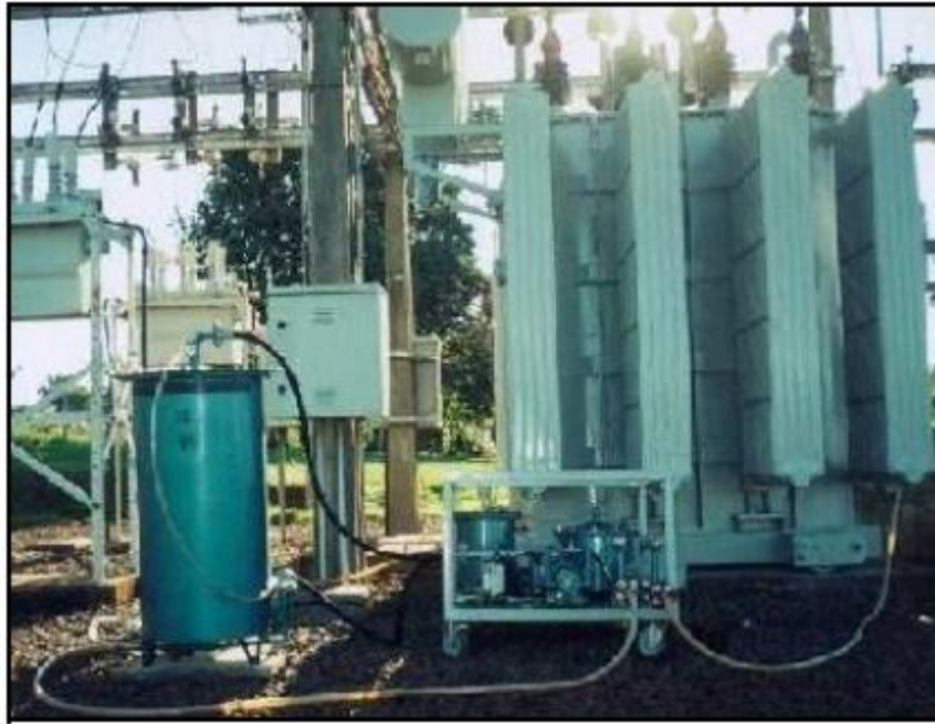
Figura 5: Unidade regeneradora de OMI em uso, em uma empresa elétrica.
