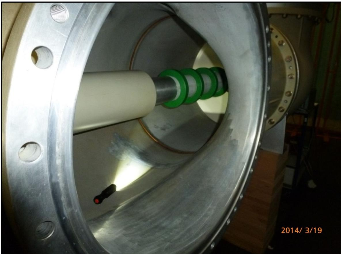
Figura 35 – Vista da parte interna do barramento blindado mostrando os toroides montados sobre trecho do condutor com diâmetro reduzido.
