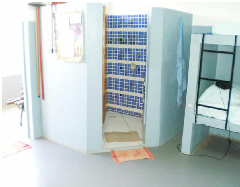
Figura 04 – Banheiro da cela do Regime Fechado da APAC-PA. Fonte: Dados da pesquisa.
