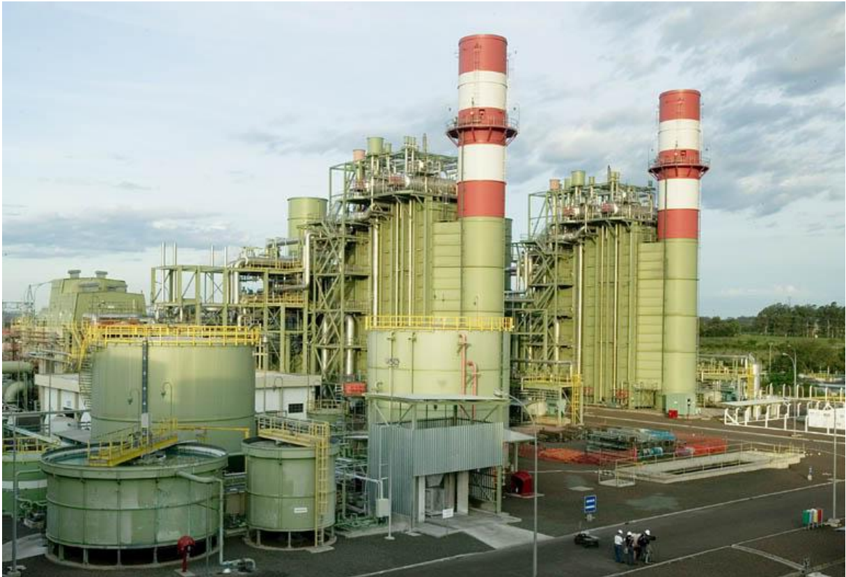
Figura 3.2 - Termelétrica de Uruguiana
