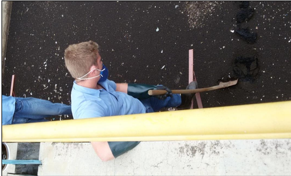
Figura 4.4 - Coleta do lodo no leito de secagem na ETE Sapucaí.
