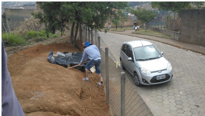
Figura 28 - Proteção das caixas com lona preta e cadeado.
