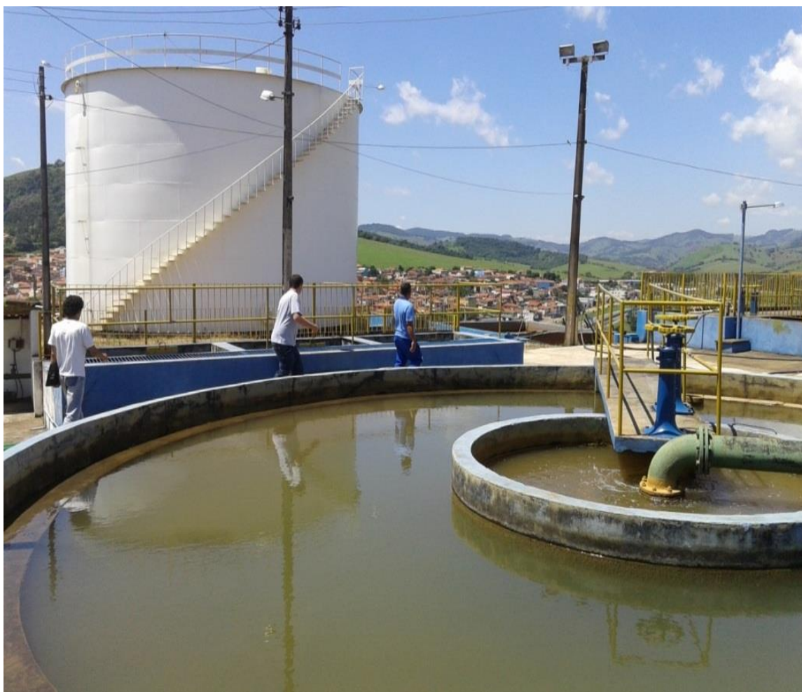
Figura 9 - ETA (estação de tratamento de água).
