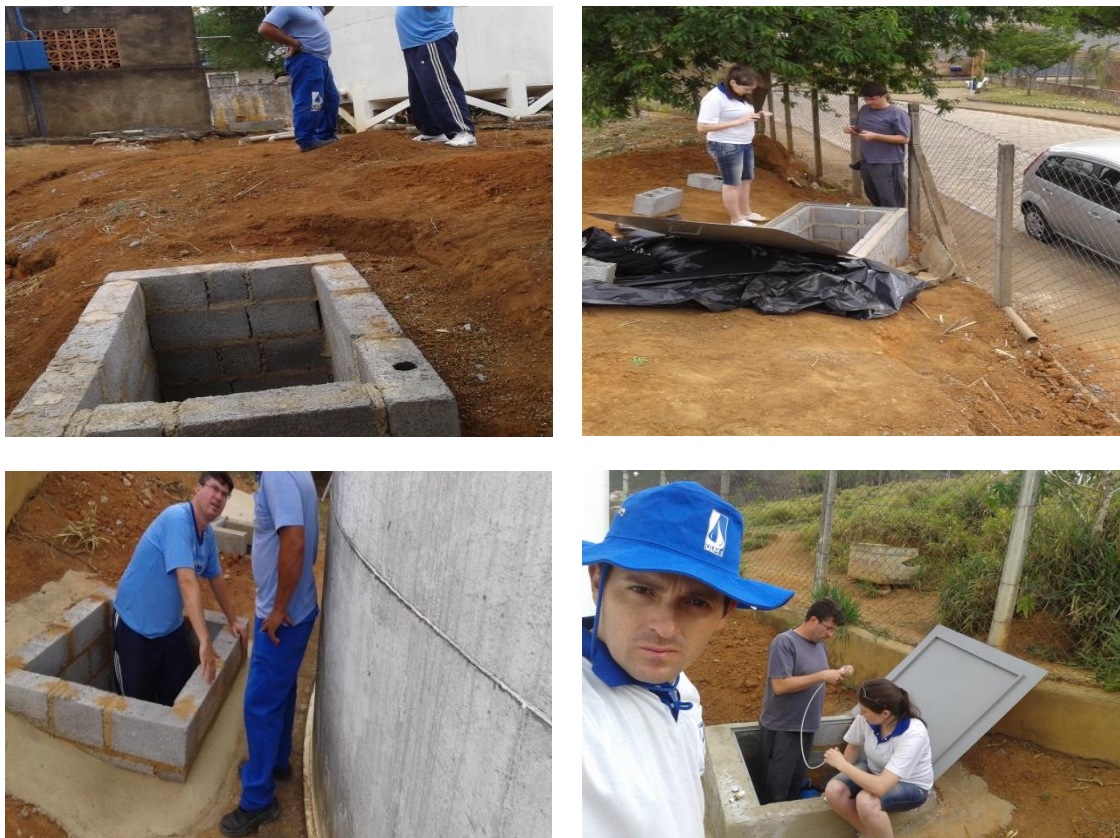
Figura 12 - Adequação do ponto de monitoramento para receber os equipamentos.
