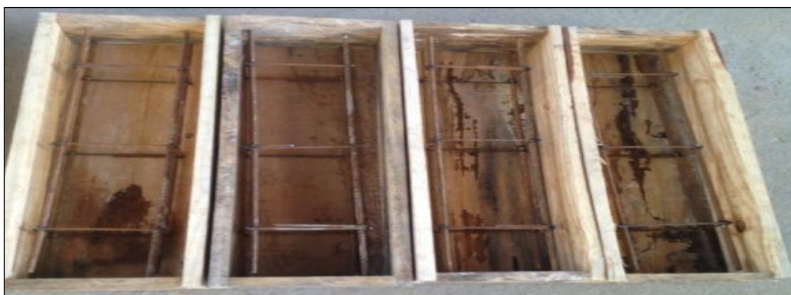
Figura 21 - Armação dentro das formas.
