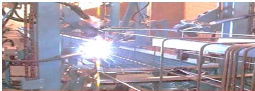
Figura 17 - Processo de soldagem. Fonte: www.progress.com
