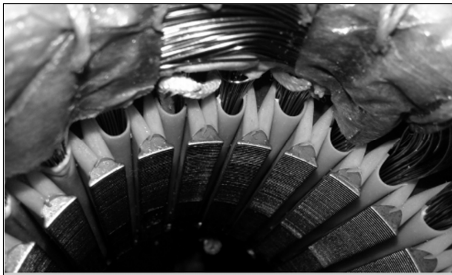
Figura 5.3 - Termopar tipo K instalado no enrolamento do estator.
