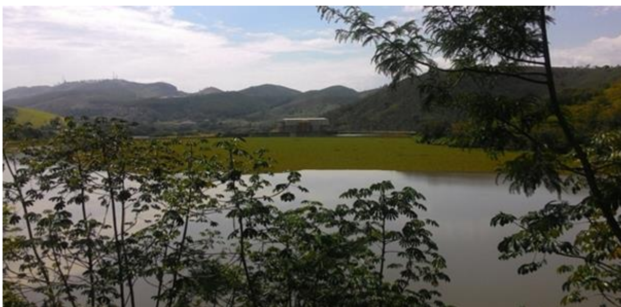
Figura 26. Usina de Furnas, ao fundo, instalada no Rio Paraíba do Sul.
