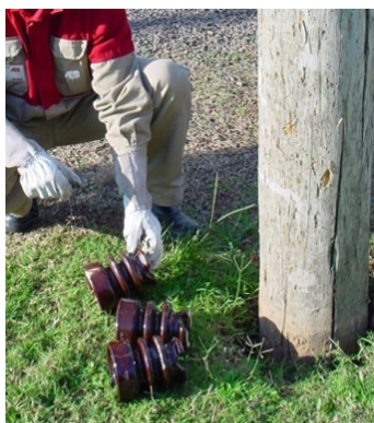
Figura 3.1 – Isoladores removidos da linha
