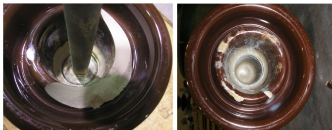
Figura 3.2 – Isoladores com anomalias
