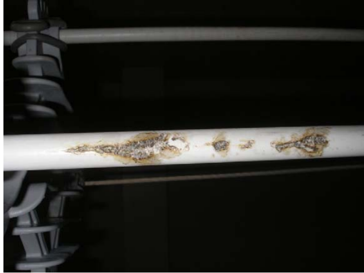
Figura 2.1 - Fotografia de falha ocorrida em cabo coberto durante ensaio de compatibilidade dielétrica.
