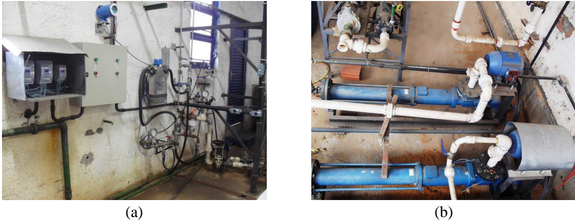
Figura 4.5. (a) Sistema de controle e medição das vazões de líquido e (b) bombas de cavidade progressiva.
