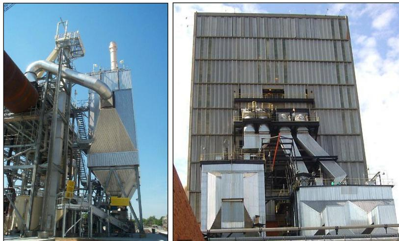
**Figura 42** - Precipitador eletrostático do forno de cal e da caldeira de recuperação.
