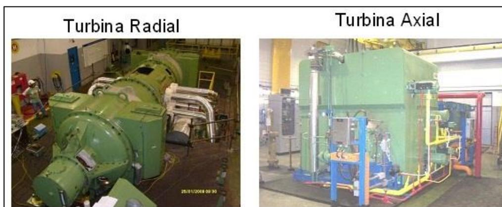
**Figura 36** - Turbinas à vapor de extração e contra pressão.
