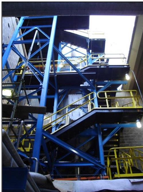
**Figura 52** - Vista do lavador de gases do tanque dissolvedor.
