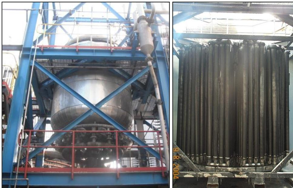
**Figura 53** - Vista dos elementos filtrantes do filtro pressurizado de licor verde .
