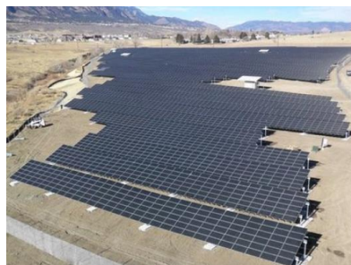
Figura 25. Sistema fotovoltaico de inclinação fixa no aterro em Fort Cason, Colorado. Fonte: USEPA & NREL, 2013.
