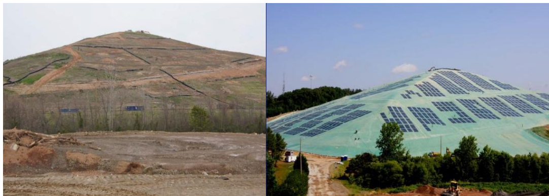
Figura 21. Cobertura solar do aterro de Hickory Ridge em uma área 4 ha, de uma área total de 16,2 ha. Fonte: HDR, s.d.
