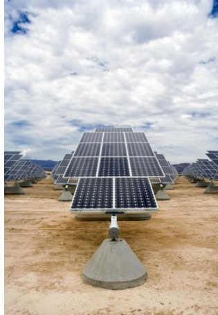
Figura 24. Sistema solar com rastreamento em um eixo utilizando na Nellis Air Force Base, Nevada-EUA. Fonte: USEPA & NREL, 2013
