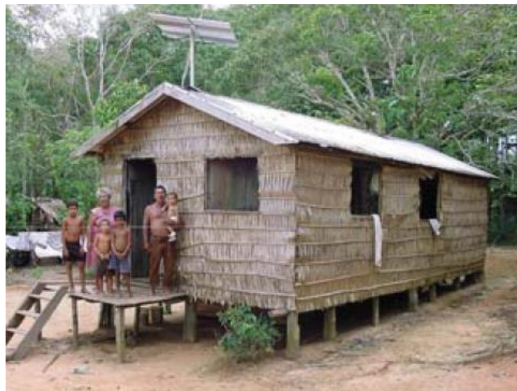
Figura 12 - Residência de baixa renda atendida por energia solar fotovoltaica. Fonte: CEPTEL, 2009.
