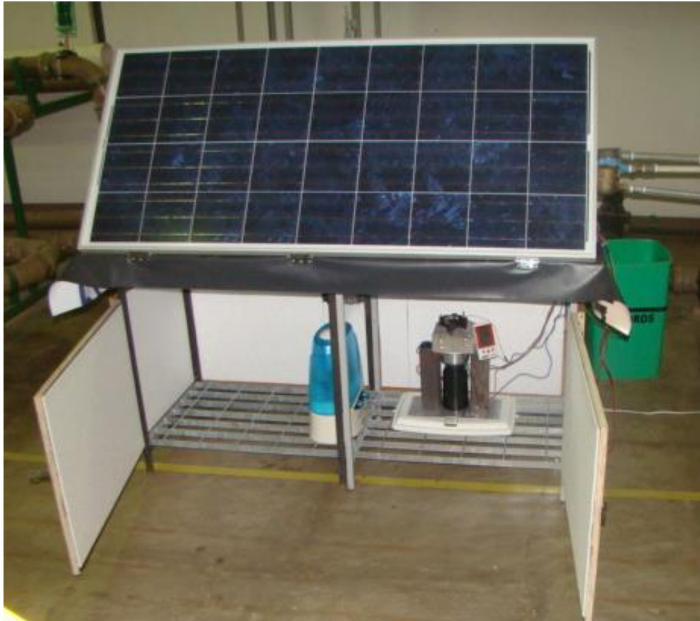
Figura 21 - Vista do condensador no interior do abrigo.
